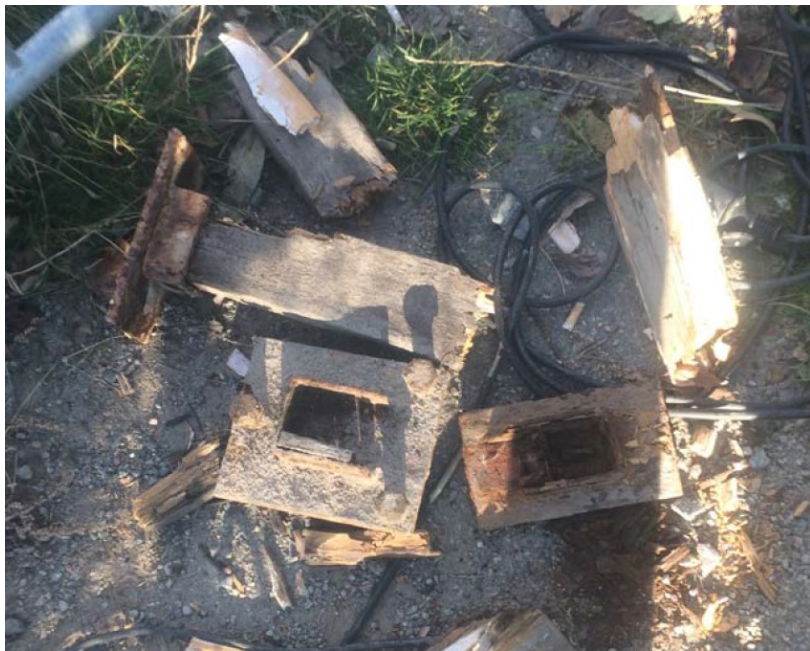
Material från silons konstruktion som lastats ut
