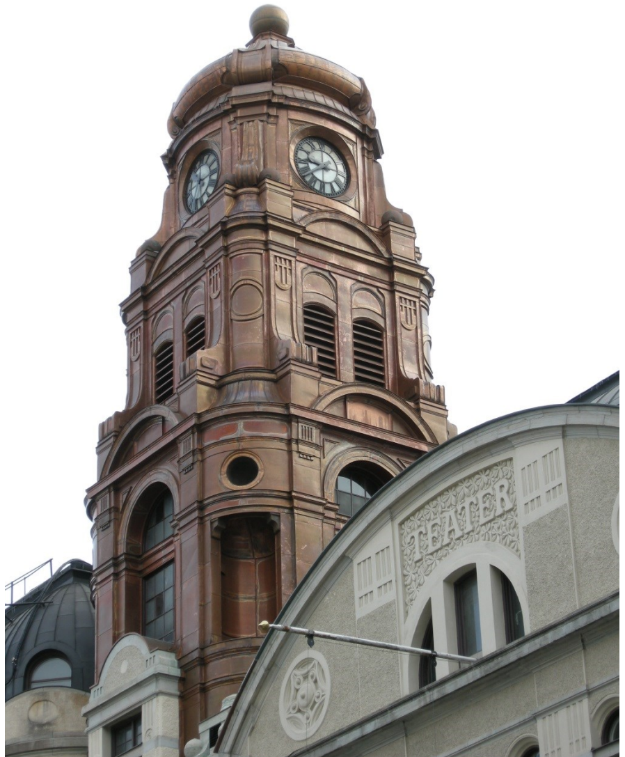
Klocktornet på Oscarsteatern försett med ny kopparplåt, februari 2016.
