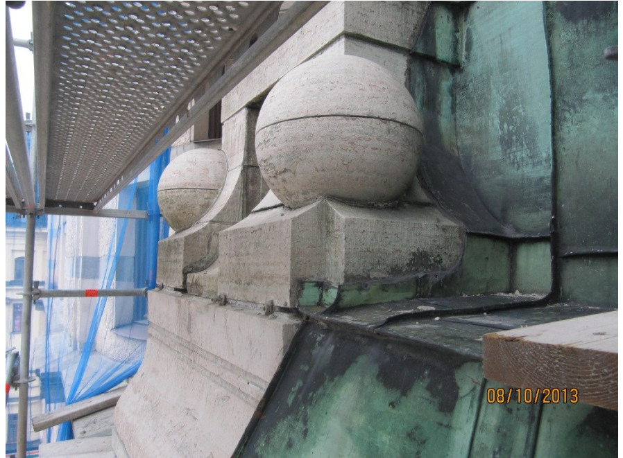
Vissa utsmyckningsdelar tillhörande taket riskerade att lossna och ramla ner om inte åtgärder vidtogs.
