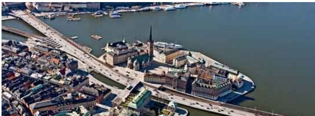
Figur 7. Vy över Getingmidjan. (Källa: www.trafikverket.se )
