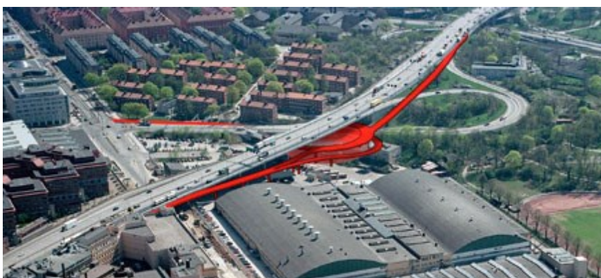
Figur 6. Den nya trafikplatsen vid Kristineberg. (Källa: www.trafikverket.se )
