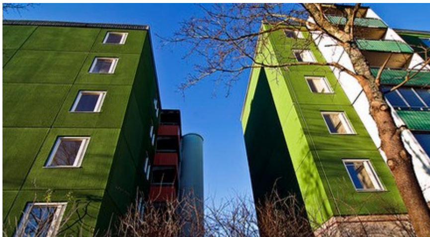
Bostadshusen i Järva byggdes under 1960- och 1970-talen och behöver rustas upp (Trondheimsgatan 30-32 före renowing).
