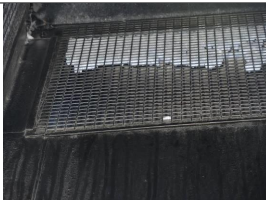
Figur 18 b: Här har den mesta snön försvunnit och den fria arean är nästan normal. Platsbesök 30/12-15.
