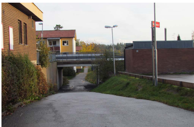
Brant gång- och cykelväg i koppling till tunnel under Markörstigen vid Markörplan
