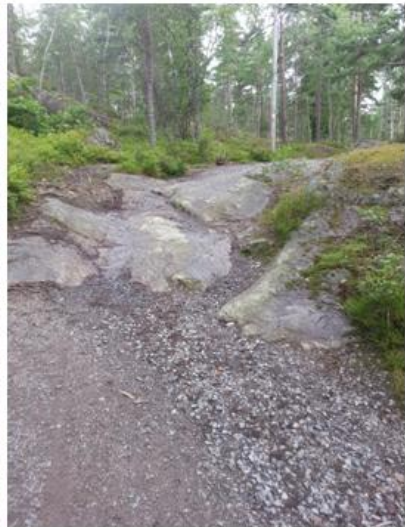
Spåret går bl a över en ojämn stenhäll. Med hjälp av fyllnads- massor och sten går det att jämna ut alltför knixiga partier. Ett alternativ är att anlägga en träramp som passage.
