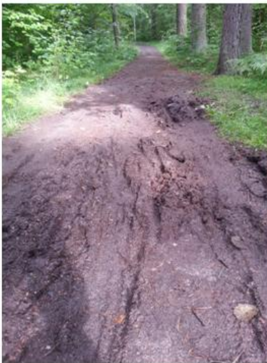
Sträcka med sank mark. Hela spåret är i behov av bättre och jämnare underlag.
