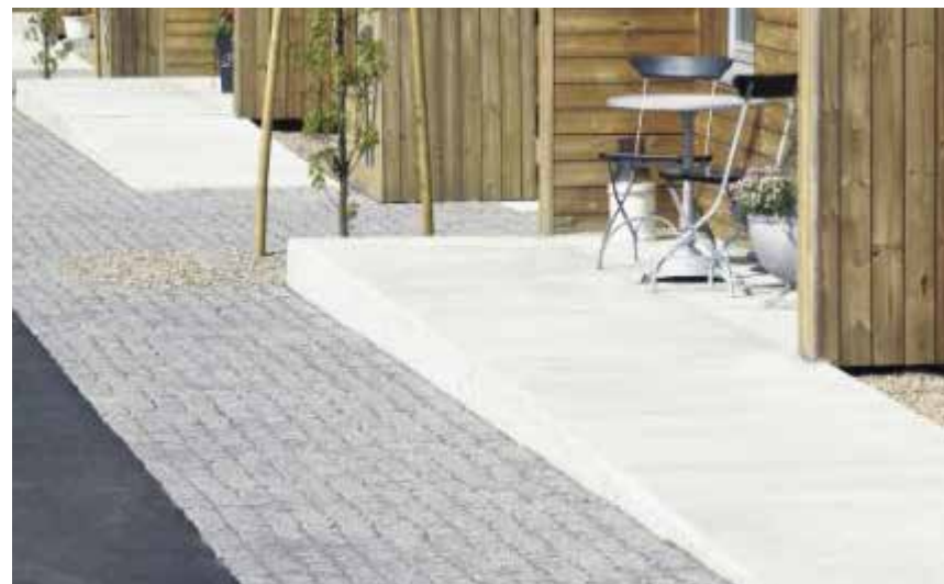
Referens genomsläppligt markmaterial, samt entréstege i betong. Referens: Pumpkällehamen av Viskaforshem.
