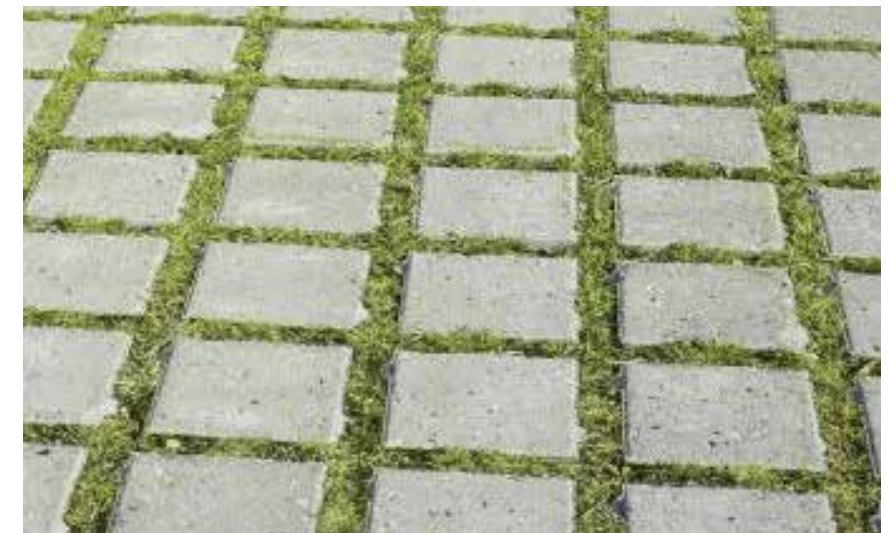
Referens betongmarksten med öppna fogar.
