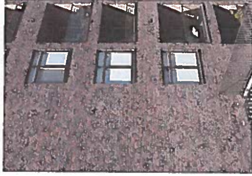
10. TEGELRÄCKEN VID INDRAGNA BALKONGER RACKARBERGEN, JOLIARK
