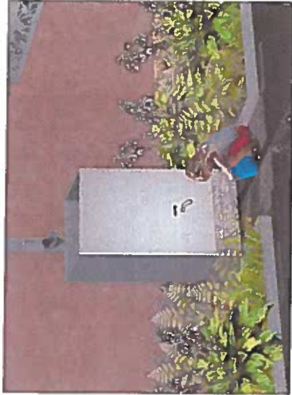
14. REGNSKÖRDARTUNNA ANPASSADE FÖR FLERFAMILJSBOSTÄDER. DET BRÄDDADE TAKVATTNET FÖRDRÖJS OCH GÖRS TILLGÅNGLIGT FÖR PLASKLEKAR OCH BEVATTNING. STUPRÄNNAN SOM Fyller TUNNAN MED REGNVATTEN KAN STALLAS OM SÅ ATT TAKVATTNET VID KALLARE TIDER, DÅ TUNNAN SKA VARA TÖMD, LEDS BORT.
