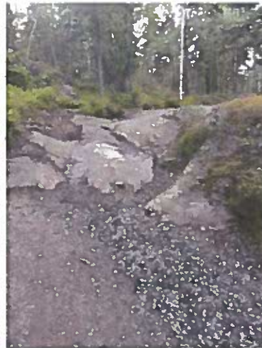
Spåret går bl a över en ojämn stenhäll. Med hjälp av fyllnads- massor och sten går det att jämna ut alltför knixiga partier. Ett alternativ är att anlägga en träramp som passage.
