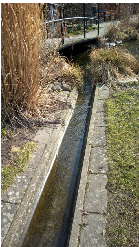
Figur 11. Liten kanal/ränn för dagvattenhantering i Augustenborg, Malmö. Foto: Maria Roldin
