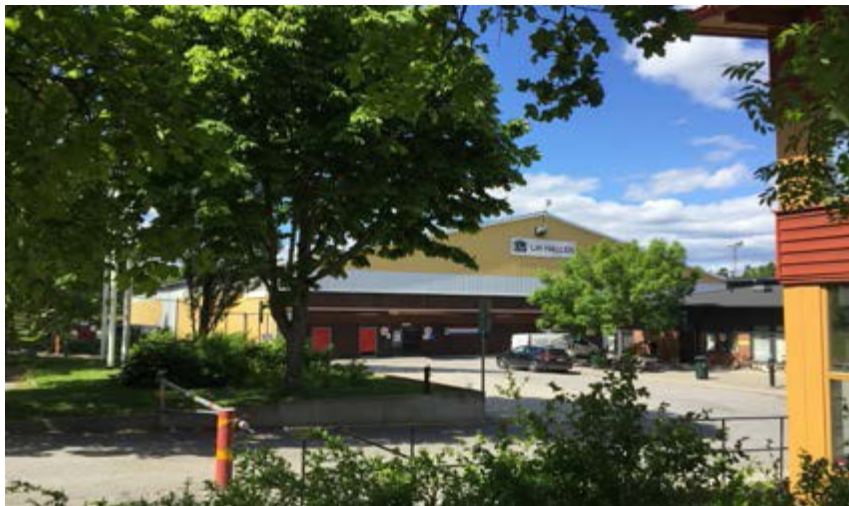
Sättra IP exteriört
