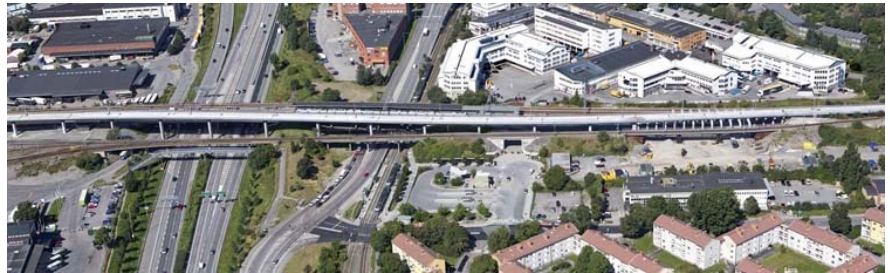
Fig. 8. Älvsjöbågen över Transportvägen, Nybodakopplet och Årstabergsvägen
