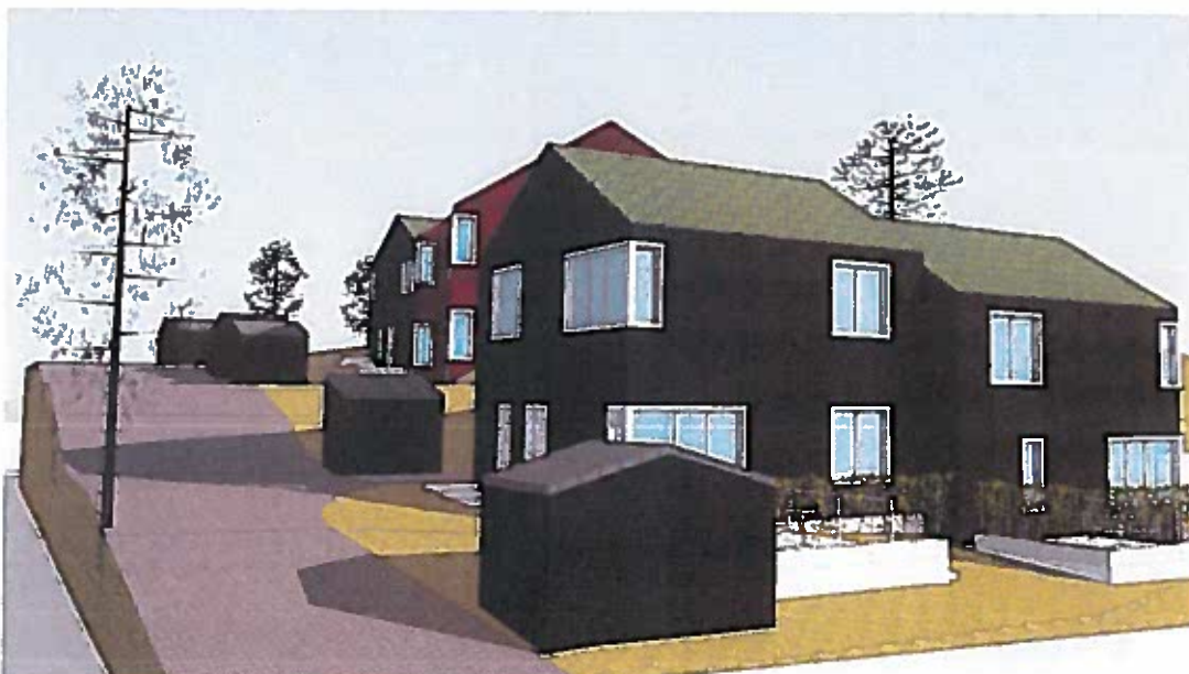
Ny bebyggelse, infart från Ävägen. I förgrunden syns byggnad för återvinning.
