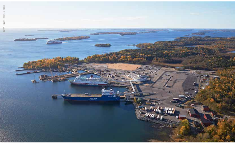
▲ Stockholms Hamnar har under 2015 arbetat med att öka andelen förnybar energi bl.a. genom att sätta upp solceller på två av bolagets tak. Nu finns solcellsanläggningar i Stockholm, Nynäshamn och Kapellskärs ( bilden ).
