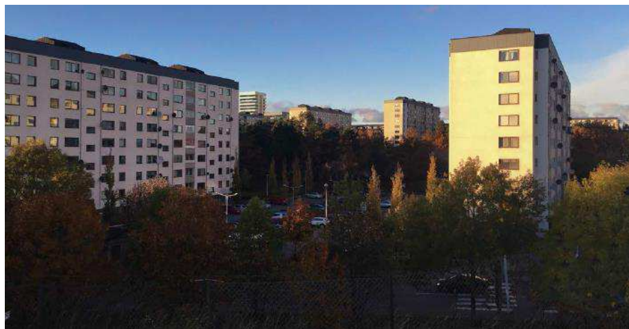
Vy från Bredängs tunnelbanestation OWC Arkitekter
