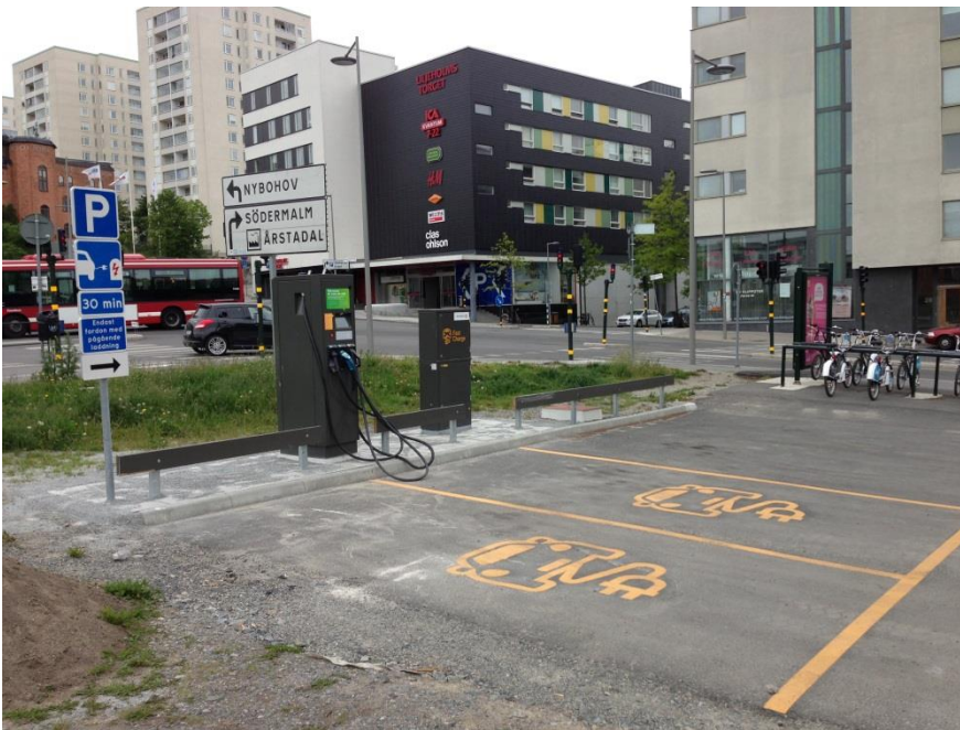
Snabbladdare på gatemark vid Liljeholmsavfarten. På den här platsen finns tilläggstavlan "Endast fordon med pågående laddning" trots att det är på gatumarken. Det blir betydligt tydligare för trafikanterna.
