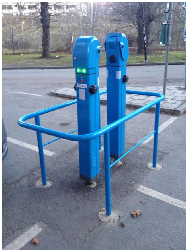
Det kan vara bra att sätta upp påkörningsskydd framför laddstolpar på utsatta platser. Bilden kommer från Stockholm Parkerings anläggning vid Eriksdalsbadet.
