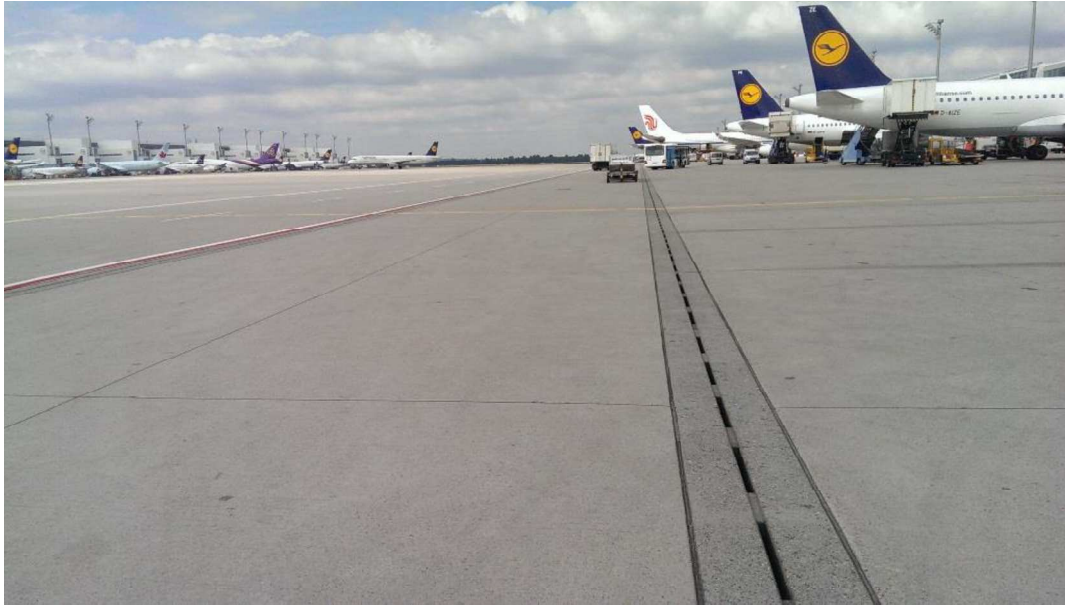
Figur 3.2: Exempel dränering ramp, Münchens Flygplats.
