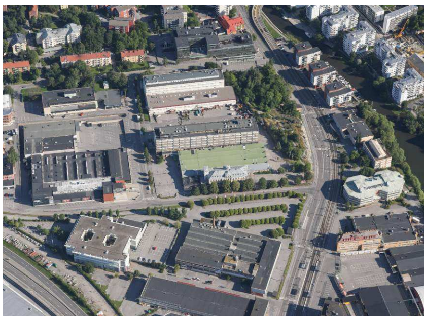
Flygfoto över planområdet med omgivning. I överkant syns delar av de karaktäristiska flerbostadshusen och i nederkant den typiska verksamhetsbebyggelsen. I mitten syns "Slottet" och "Sågtandsbyggnaden".
