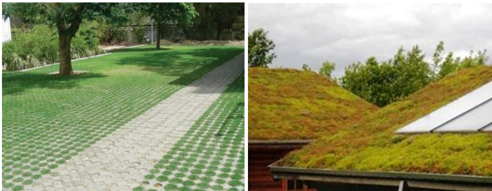
Exempel på dagvattenförbättrande åtgärder. T.v. Parkeringsplats med s.k. armerat gräs och t.h. sedumklädda tak.
