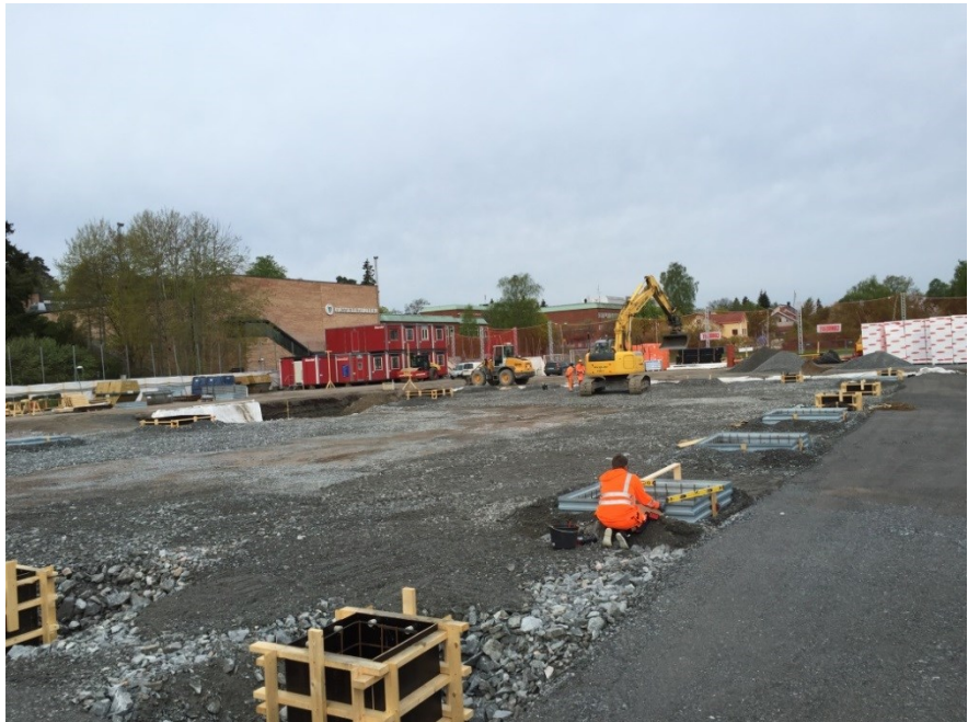
Arbetsplatsen efter genomförd sanering
