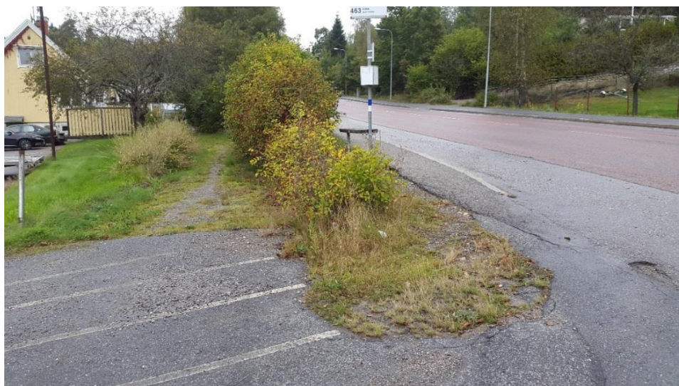
Figur 19. Dike saknas mellan väg 274 och befintlig bebyggelse. Vägområdet är mycket ottydligt, men har tolkats in vid släntfot. Vy ifrån öster.
