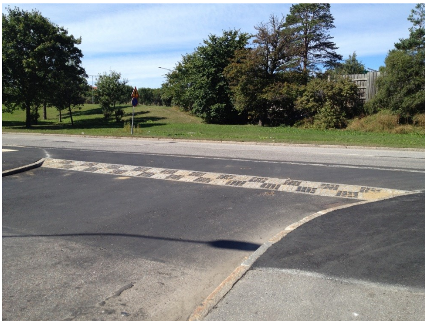
Genomgående gång- och cykelbana i korsningen Kontrollvägen/Diamantbacken.
