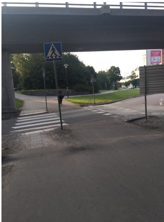
Upphöjt övergångsställe vid Västbergapåfarten.
