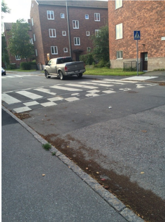
Upphöjt övergångsställe på Klensmedsvägen.
