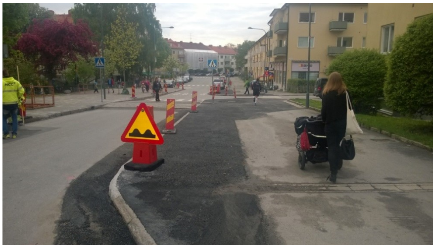
Utanför skolans entré efter ombyggnad.
