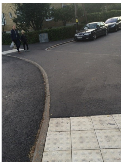
Genomgående gångbana vid Sågverksgatan efter åtgärd.
