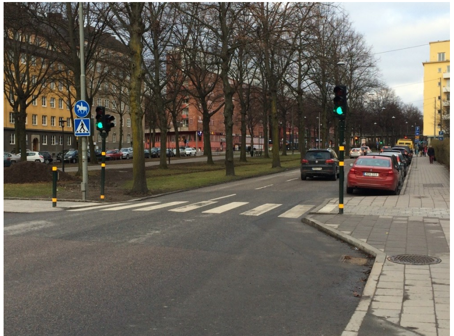
Bild före (google.maps) och efter åtgärd i korsningen Valhallavägen/Banérgatan. Trafiksignal och utbyggt öra vid tidigare obevakat övergångsställe.
