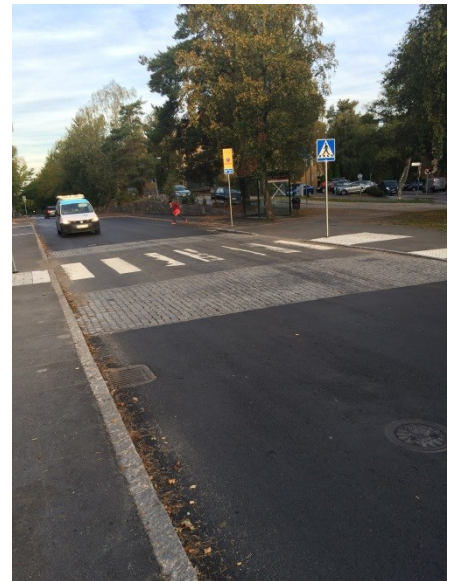
Upphöjt övergångsställe på Skönsmovägen, före och efter åtgärd.
