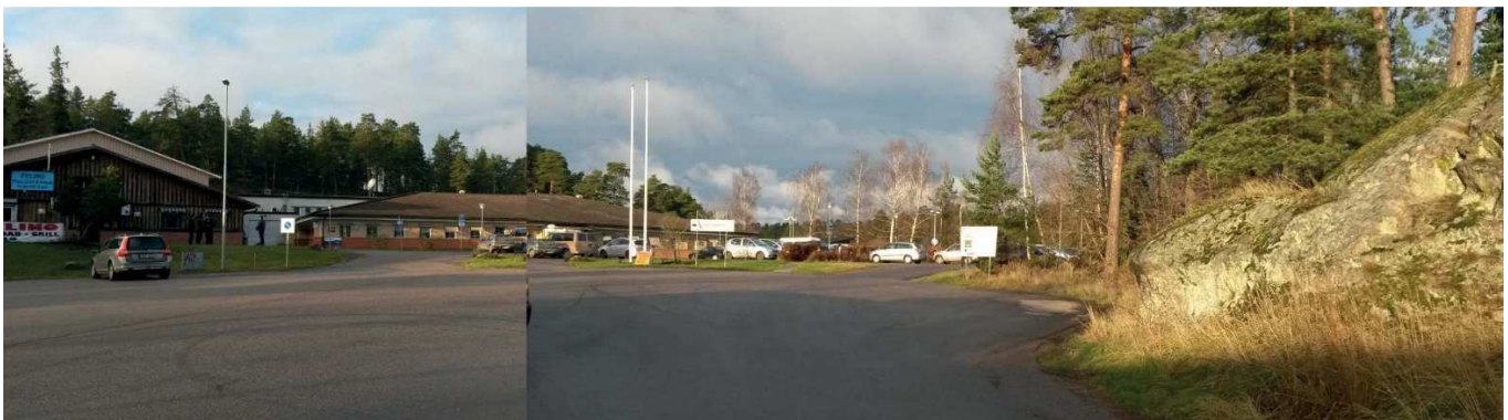
Fastigheten idag med kontors- och lagerlokaler.
