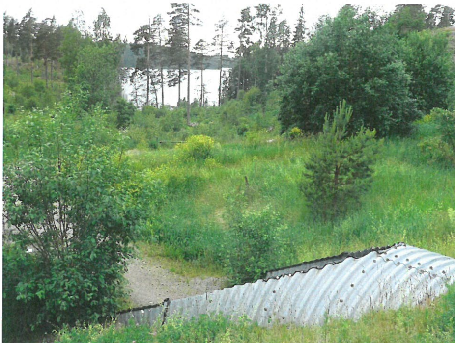
Figur 18. Rörebro strax söder om Lämshagakorset. Vy väster om väg 646. Sjön Långträsket syns i bakgrunden.
