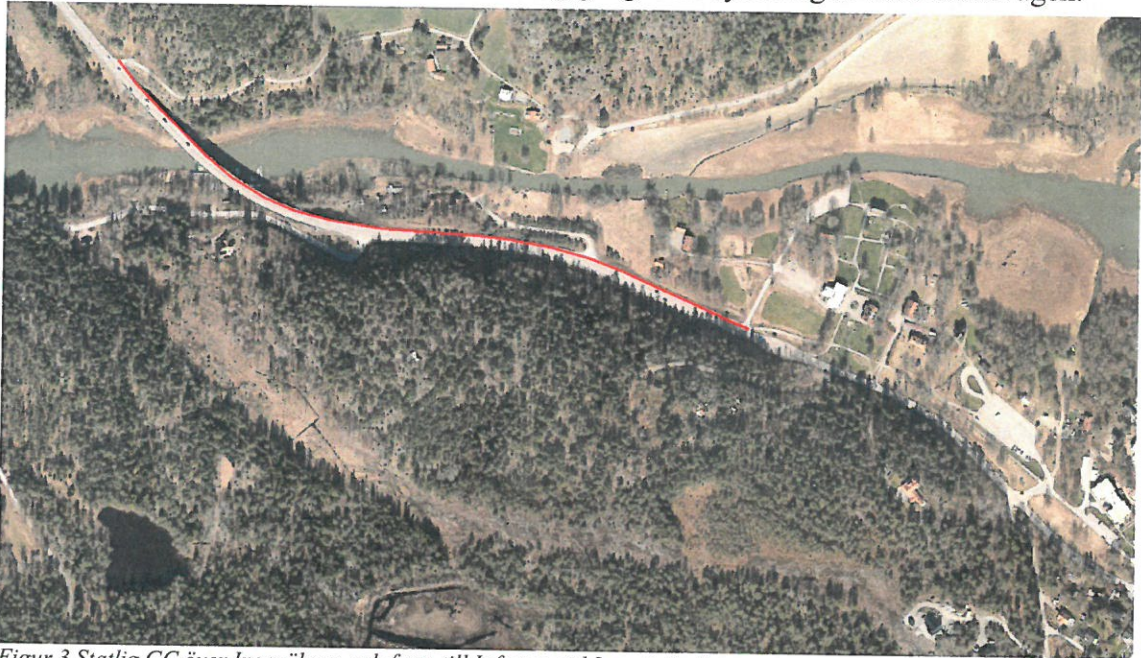
Figur 3 Statlig GC över Ingaröbron och fram till Infarten vid Ingarö Kyrka
