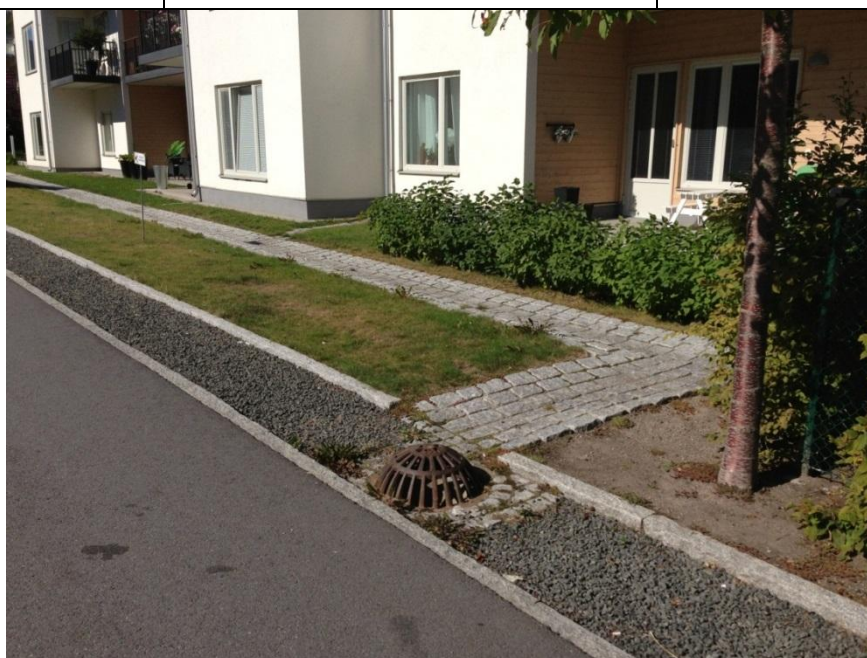
Figur 13 Tak och gatuavvattning i ett öppet, fördröjande stråk.
