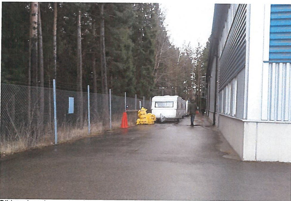
Bilden visar den västra sidan av fastigheten Lastbilen 7, sett från norr. Till vänster syns den skogsmark som i planförslaget tas i anspråk för utbyggnad av icke störande industriverksamhet.
