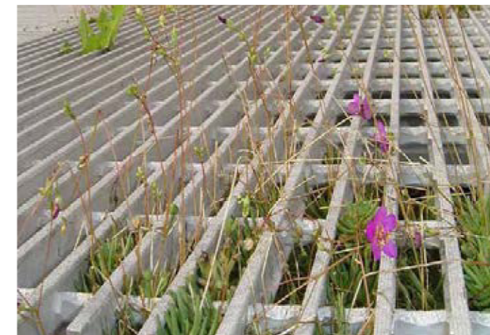
Rännorna planteras och beläggs med körbar gallerdurk för att inte reducera tillgängligheten.
