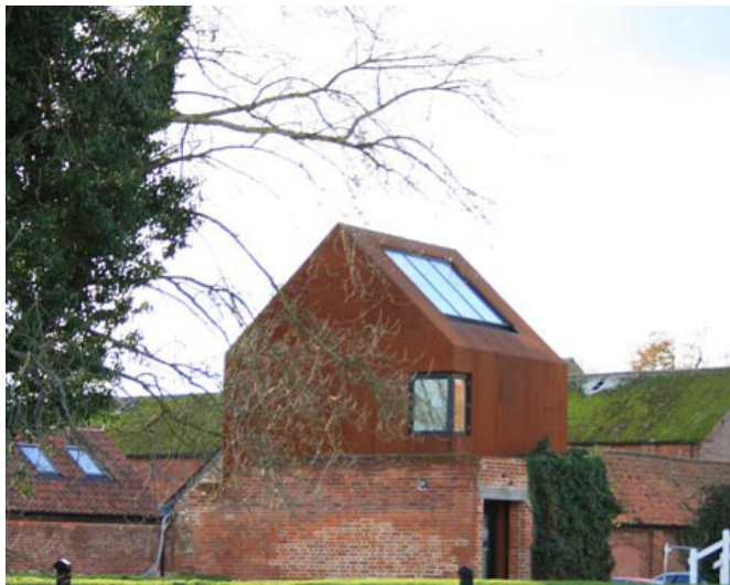
Stora takfönster (Howard Tomkins).
