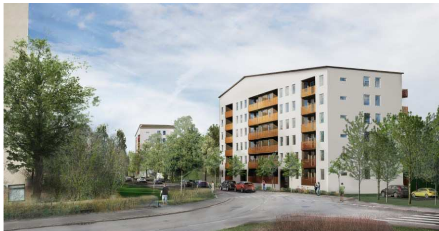
Vy från söder. Det södra fristående huset knyts samman med de två som står i par genom det gemensamma arkitektoniska uttrycket. I mellanrummet finns park som möter parken på andra sidan vägen. Illustration Ettelva Arkitekter.
