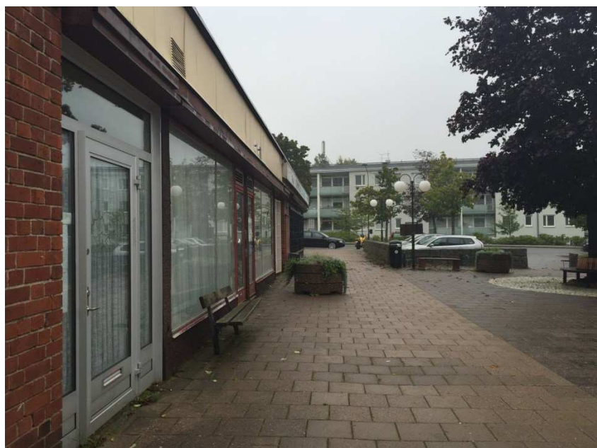
Del av torget sett från söder med befintligt hus som planeras att rivras och ersättas till vänster i bild. I bakgrunden skymtas lamellhus vid Brunskogsbacken.
