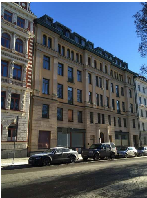
Gathusets fasad mot Sturegatan. Givet bygglov innefattar återställande av fasaden.
