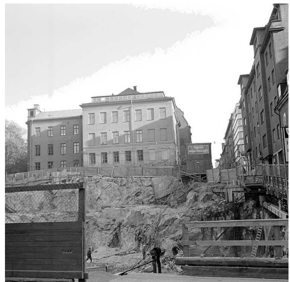
Ursprungliga byggnaden revs i samband med byggandet av tunnelbanestationen
