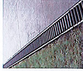
Aco drän t. ex. vid garage.
