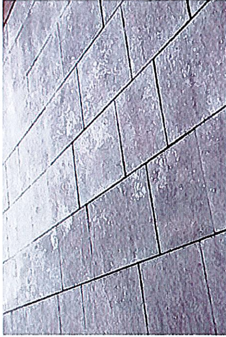
Betongplattor te x vid cykeiparkeringen.
