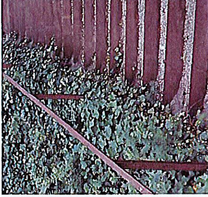
Trappar och handledare i stål.
