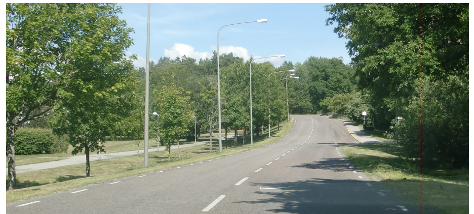
Blomsterkungsvägen, Hässelby: Cykelbana finns anlagd utanför vägområdet. Sträckan har klassats med DTSS bil/korsande.
