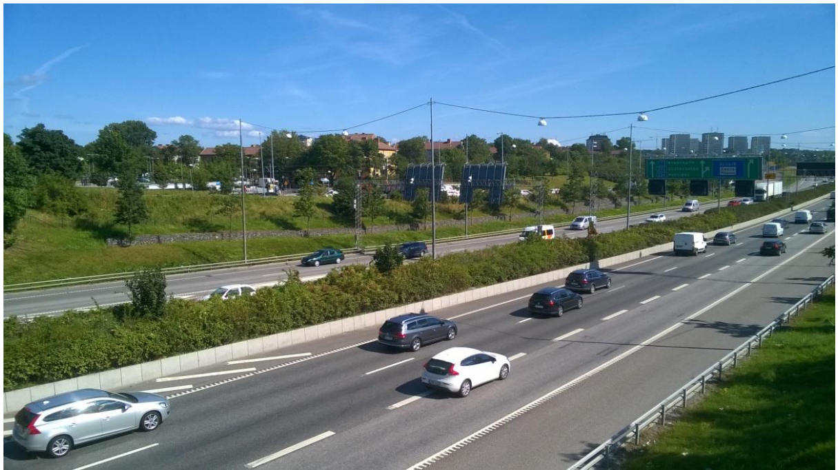
Figur 11 - Gabionmuren framträder i den vegetationsklädda slänten mellan Årstälänken och Årstabergrsvägen. Trädplanterade vallar löper längs Årstälänken och Årstabergrsvägen och utgör delvis ett bullerskydd.
