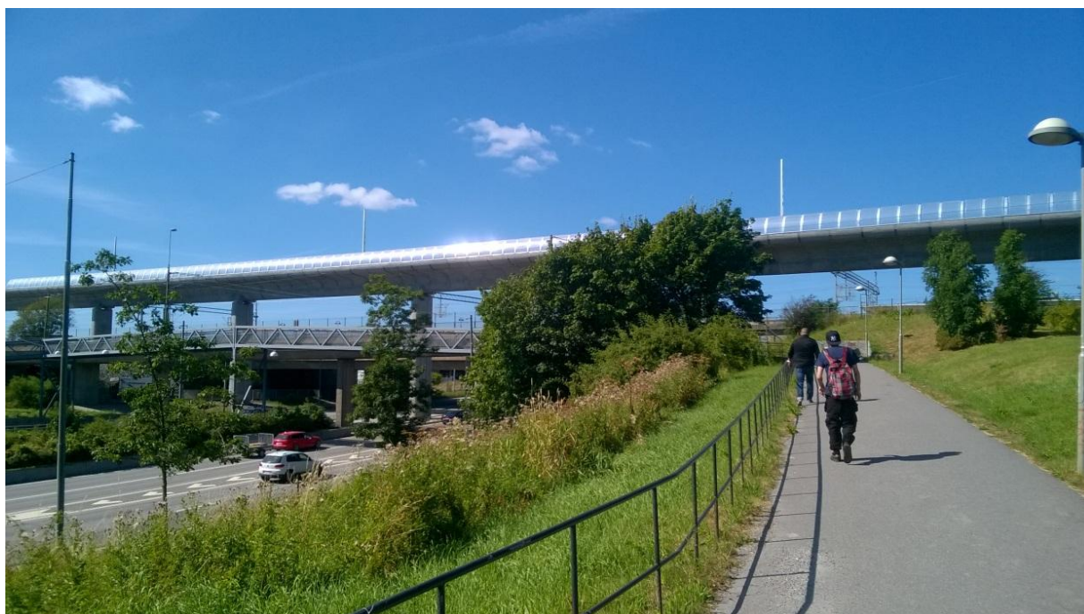
Figur 19. Årstälänken med avfart Essingeleden norrut och söderut. Gångbron över Årstälänken och den nya bron Älvsjöbågen 10 . Lönnar växer intill gångbron.
