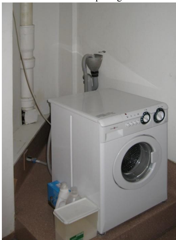
9. Tvättmaskin i passage
