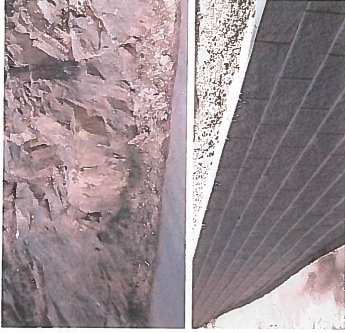
Om det går utifrån de geologiska förutsättningarna görs en bergskärning på hela ytan. Om inte så är fallet byggs en betongstensmur upp.
