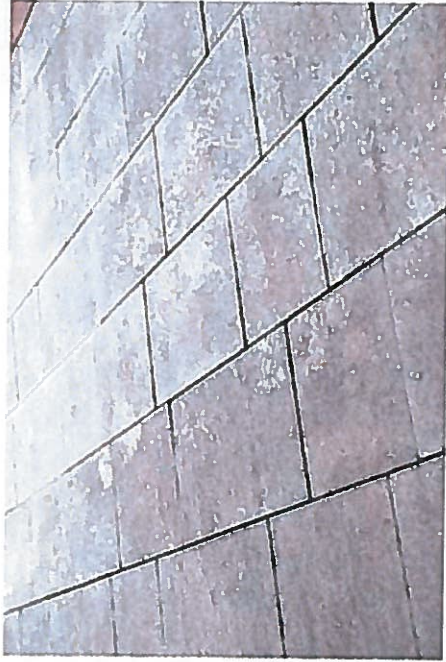
Betongplattor te x vid cykelparkeringen.
