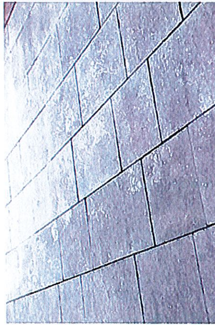
Betongplattor te x vid cykelparkeringen.
