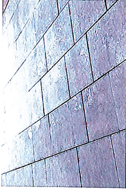
Betongplattor te x vid cykelparkeringen.
