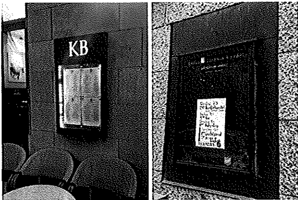
40. 41. Ett utvändigt hängt skyltskåp och ett som är integrerat i fasaden. Höjdmått på båda skyltarna är anpassade till fasadens plattindelning och båda har gott om luft till andra fasadelement.
