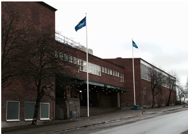
Brännkyrkahallens entré, vy från planområdet.
