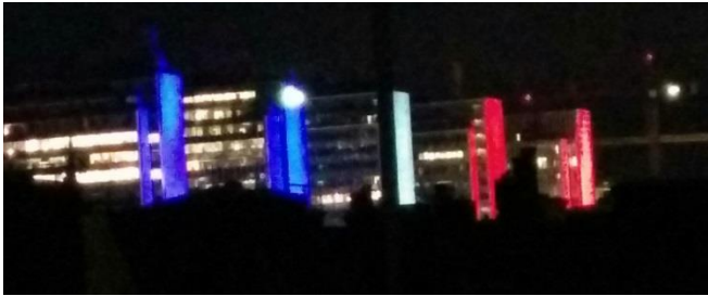
45. Hötorgscity. Hötorgsskrapornas gavlar har fasadbelysning som kan styras i detalj. Fasaderna "vilar" i perioder för att också få mer effekt när de används. Här i franska färger i november 2015.
