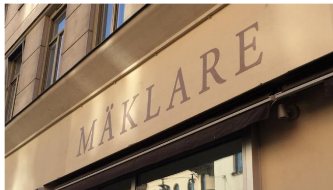
43. Scheelegatan. Skyltband i samma färg som fasaden, bokstäver i en kulör som är anpassad till fasadens färgskala, bokstäverna har ett respektavstånd till fasaddetaljer, inga varumärken gör att ommålning inte behövs vid varumärkesbyten.
