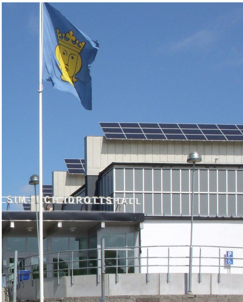
Figur 6: Åkeshovs sim- och idrottshall, Stockholms stads första idrottsanläggning med solcellspaneler uppförd år 2007 med en elproduktion på 45 MWh per år.
