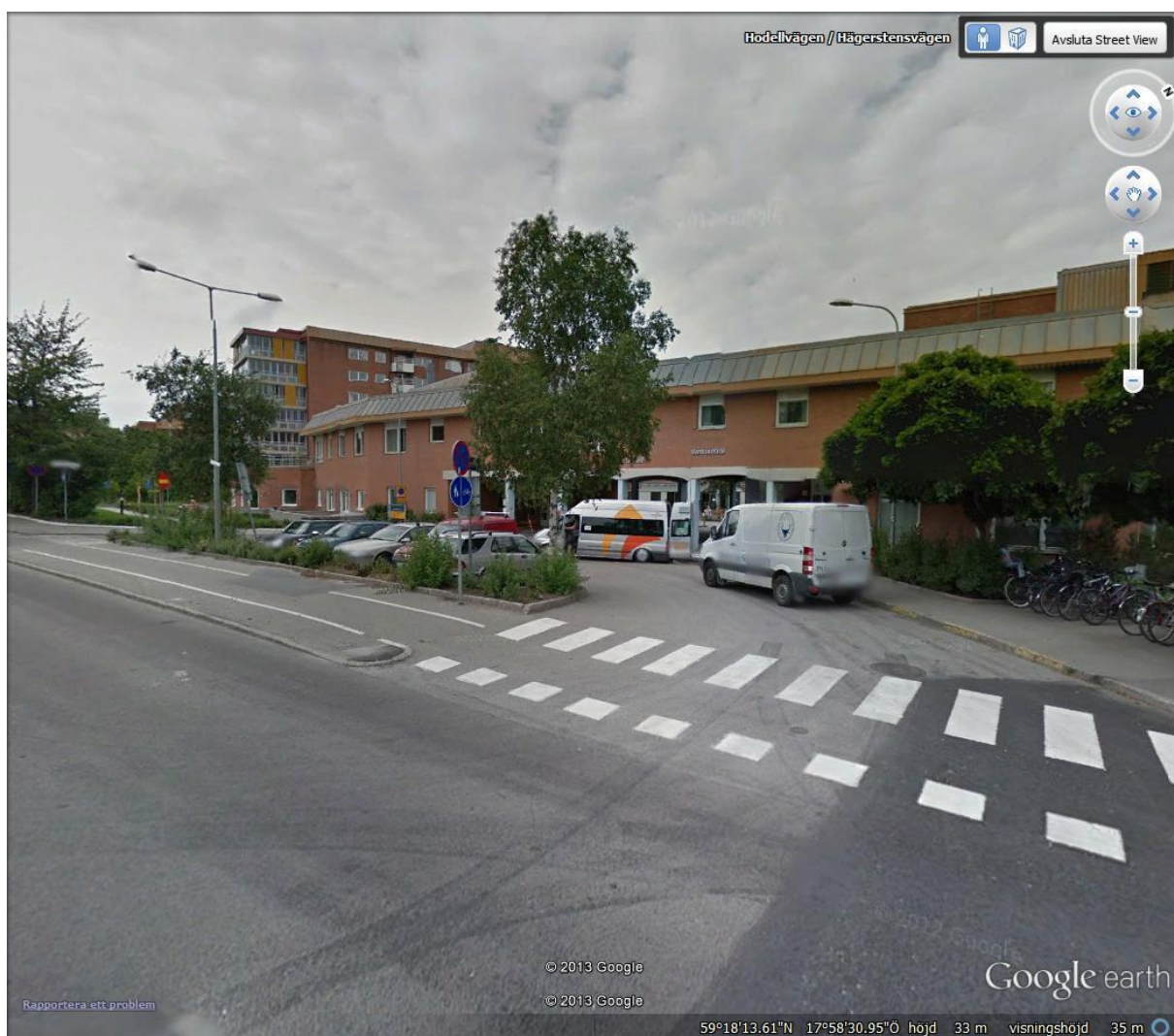
Bild 3. Vårdcentral och äldreboende på Hägerstensvägen. Ligger mitt på sträckan.
