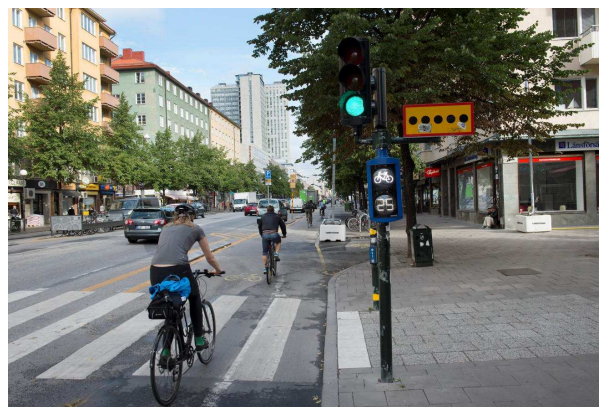
Grön våg har programmerats i bägge riktningarna, -in till stan på fm, -ut ur stan på em. Vågen är anpassad för 18 km/tim. Den har även visualiserats genom en nedräkningslykta som visar hur lång tid man har på sig att passera stolpen innan man hamnar utanför den gröna vågen.
