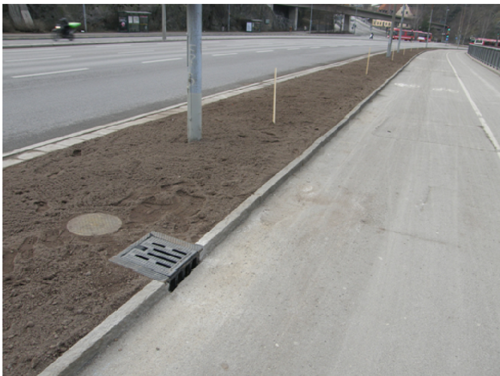
Figur 4. Exempel på försök på brunnslösning för infiltration. Trädplacering visas med stakkäppar i bilden. Foto Björn Embren Trafikkontoret.
