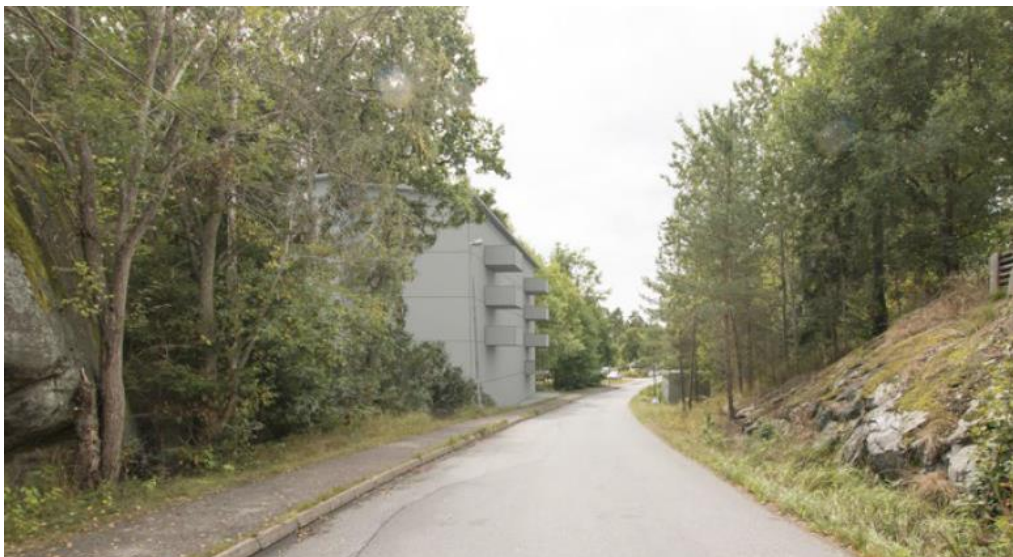
Vy Bergfotensvängen från norr
