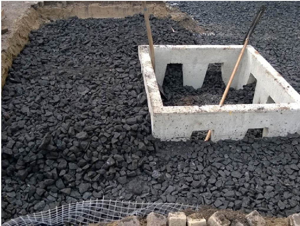
Figur 3. Exempel på försök med skelettjord med biokol i Stockholm. Foto Björn Embrén Trafikkontoret.
