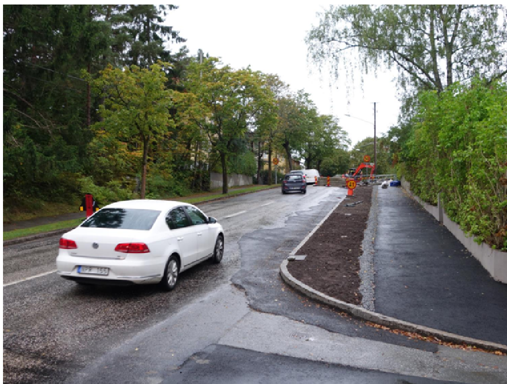
Figur 7. Västerled, ny bädd för trädplantering med infiltration från både gata och gångbana. Träden planteras senare. Foto Björn Embrén Trafikkontoret.
