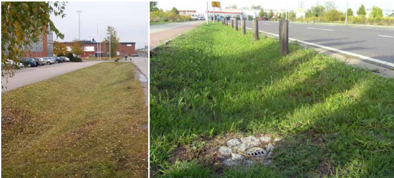
Två exempel på utformning av infiltrationsstråk. Det vänstra exemplet har en stor magasinvolym i själva diket. I det högra exemplet syns en bräddbrunn som är placerad några decimeter över diket botten.
